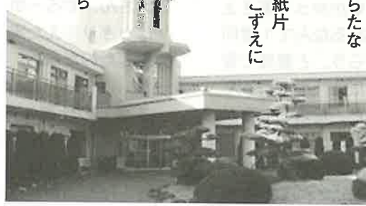
「原爆ホーム」本館
